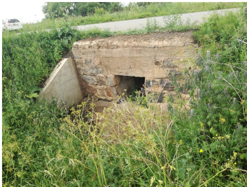
ж/б труба ПК 49+13 d=1,0*0,90 выходное отверстие
