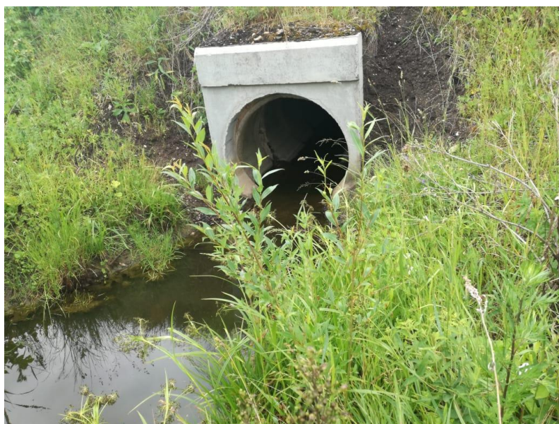
ж/б труба ПК 3+41 d=1.50 выходное отверстие
