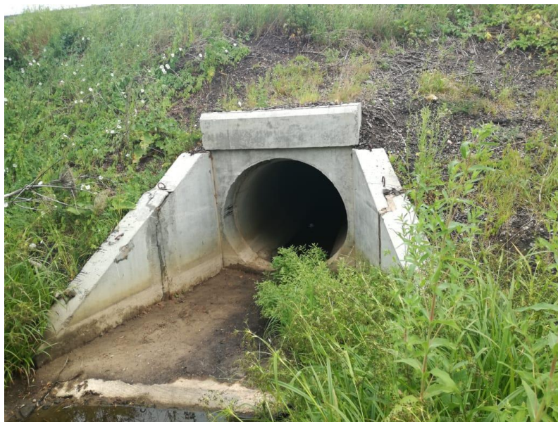
ж/б труба ПК 3+41 d=1.50 входное отверстие
