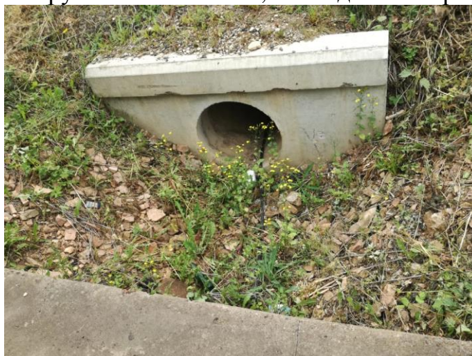
ж/б труба ПК 20+03 d=0,75 входное отверстие
