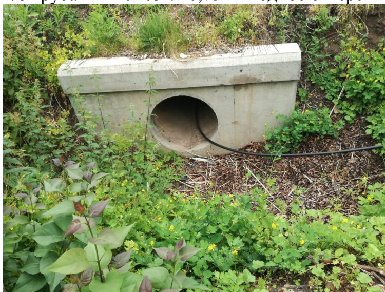
ж/б труба ПК 20+03 d=0,75 выходное отверстие
