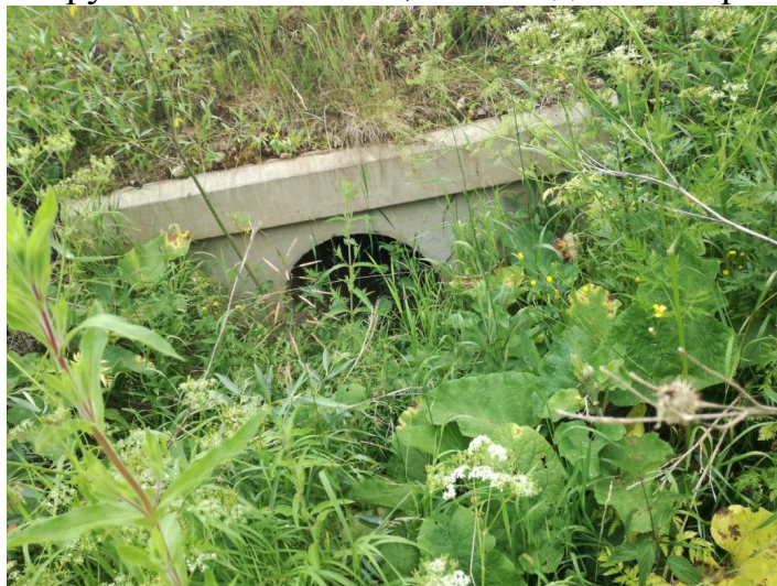
ж/б труба ПК 34+10 d=0,75 выходное отверстие
