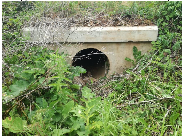
ж/б труба ПК 34+10 d=0,75 входное отверстие
